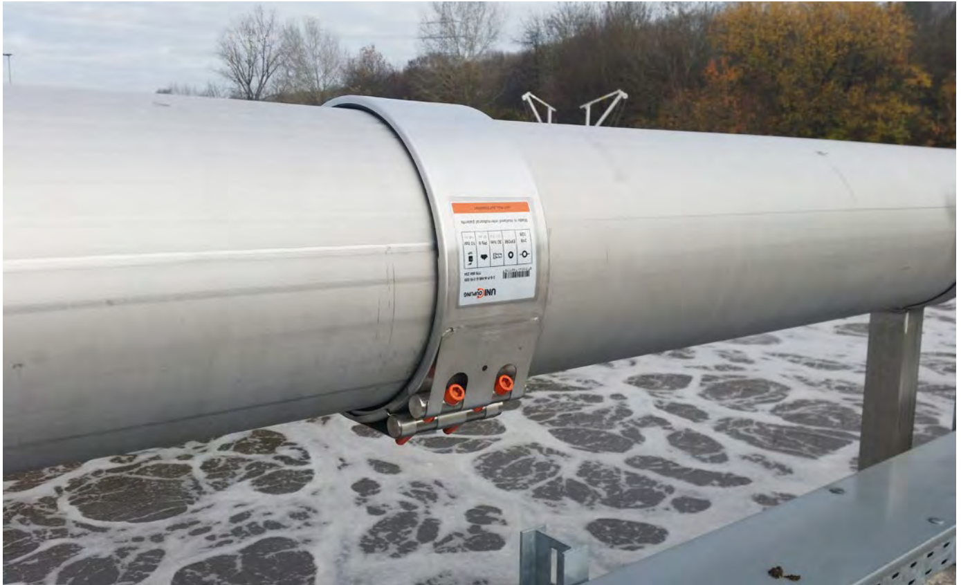
PEWOFLEX 138-F6A4E318-328 PN 10 (Rohrdurchmesser Ø 323 mm, Druckluft , EPDM)
