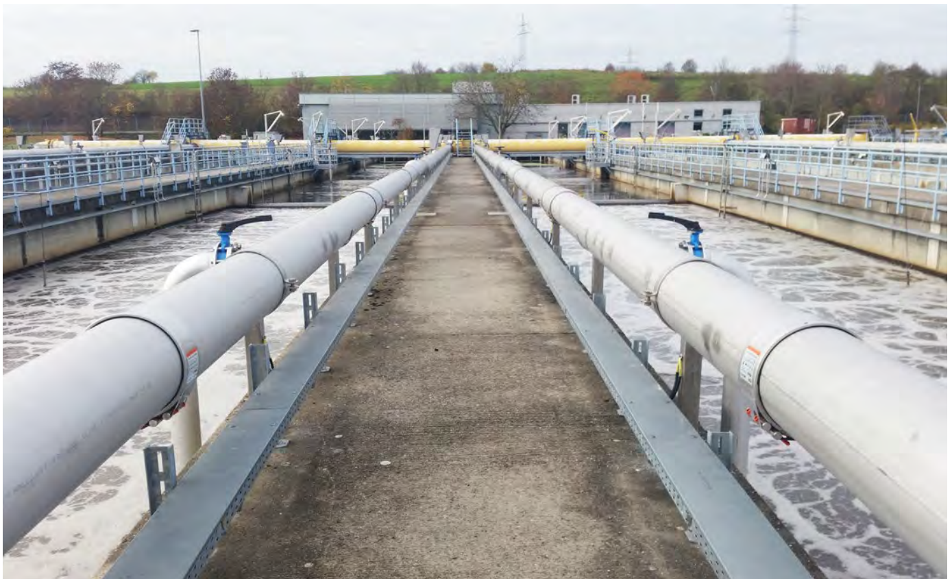
PEWOFLEX 138-F6A4E318-328 PN 10 (Rohrdurchmesser Ø 323 mm, Druckluft , EPDM)
